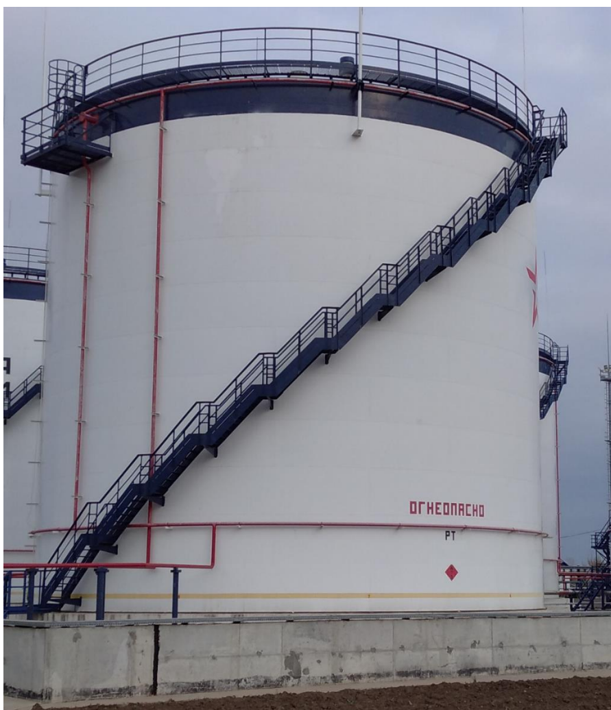
Рисунок 3 – Общий вид резервуаров РВС-4880 зав.№№ 23058/4,88, 23059/4,88, 23060/4,88, 23061/4,88
