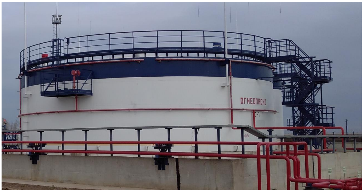
Рисунок 2 – Общий вид резервуаров РВС-1698 зав.№ 23064/1,698, 23065/1,698, 23066/1,698
