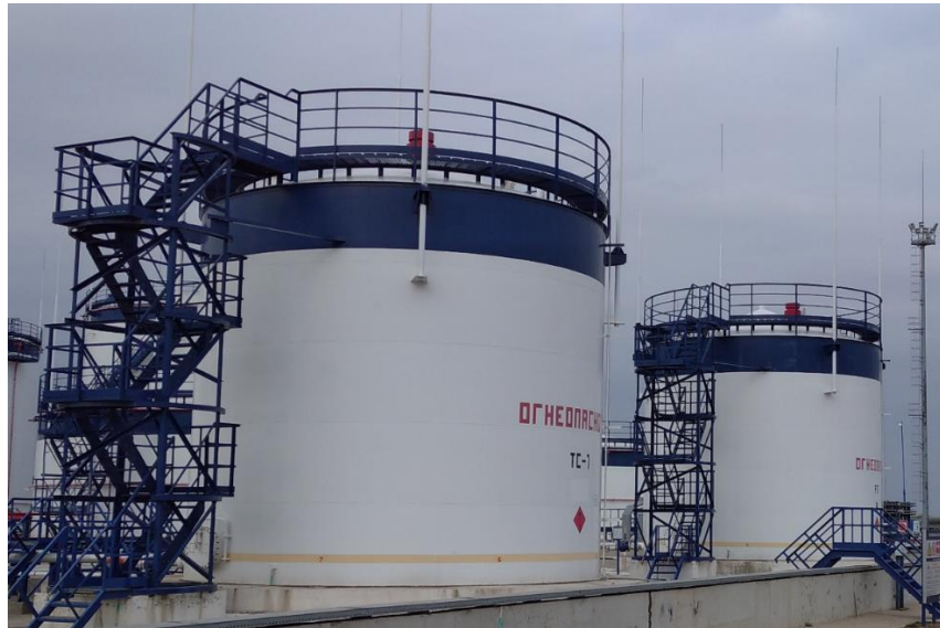
Рисунок 1 – Общий вид резервуаров РВС-429 зав. № 23067/0,429, 23068/0,429
