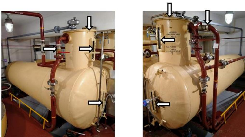
Рисунок 2 – Схема пломбировки мерников 787-М, зав.№№ 499, 500, от несанкционированного доступа, обозначение места нанесения знака поверки
