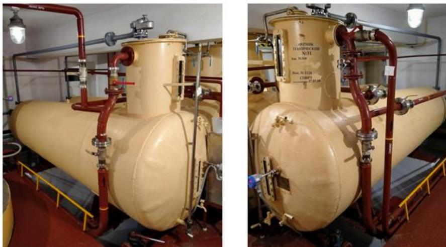
Рисунок 1 - Общий вид мерников 787-М, зав.№№ 499, 500
