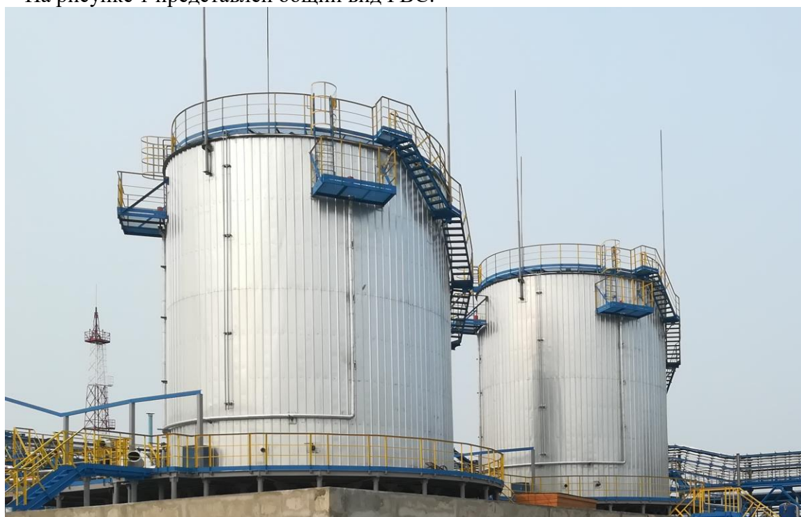
Рисунок 1 – Общий вид резервуаров стальных вертикальных цилиндрических РВС-1000, заводские номера 1 и 2
