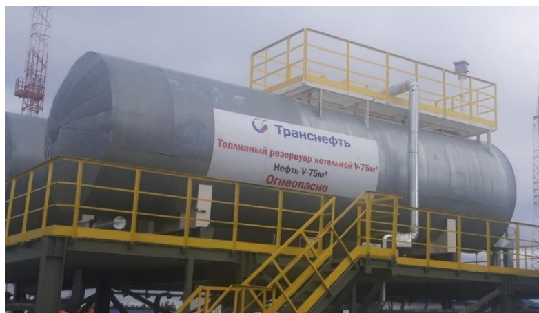
Рисунок 1 – Общий вид резервуаров РГС-75
