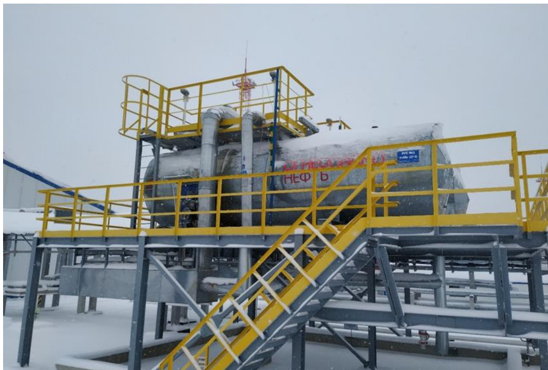
Рисунок 1 – Общий вид резервуаров РГС-20
