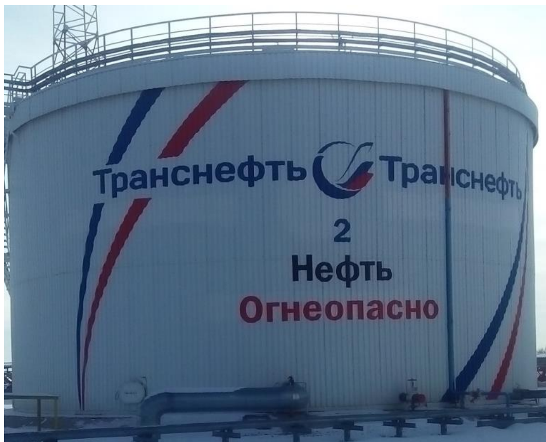
Рисунок 1 – Общий вид резервуаров РВС-5000
