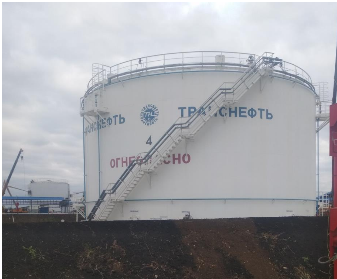
Рисунок 1 – Общий вид резервуара РВСП-5000
