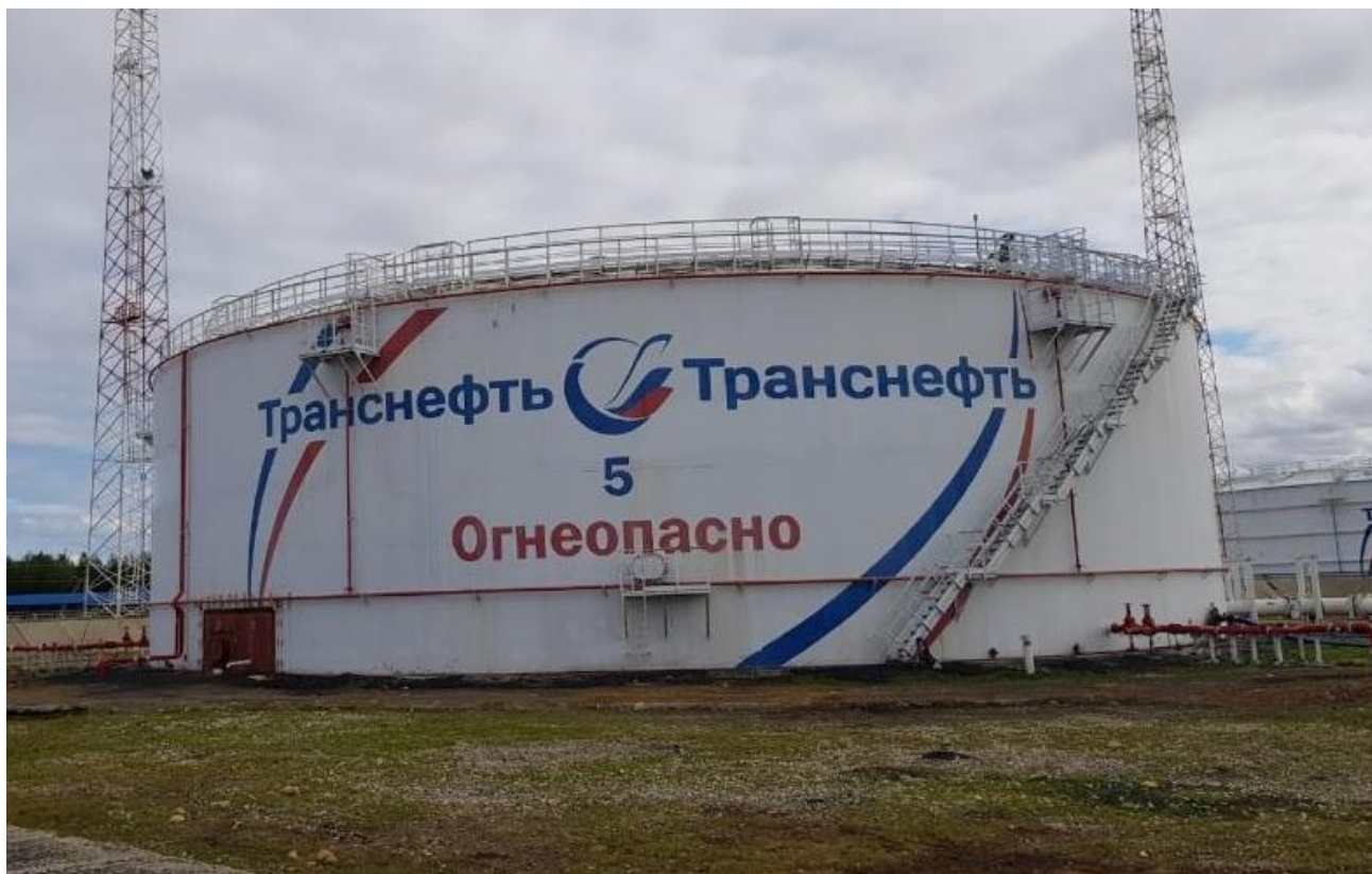
Рисунок 1 – Общий вид резервуара РВСП-20000
