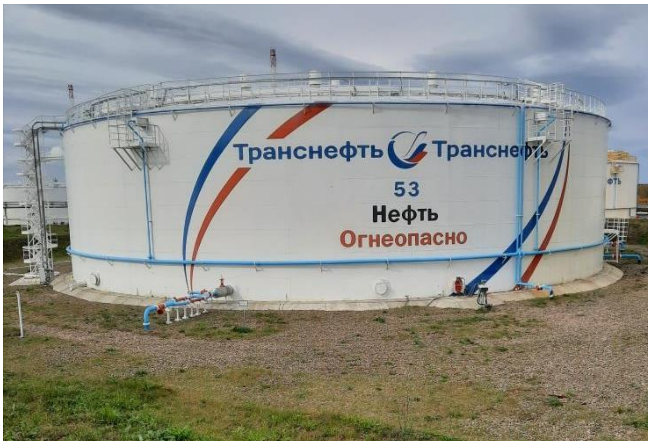
Рисунок 1 – Общий вид резервуара РВСП-20000
