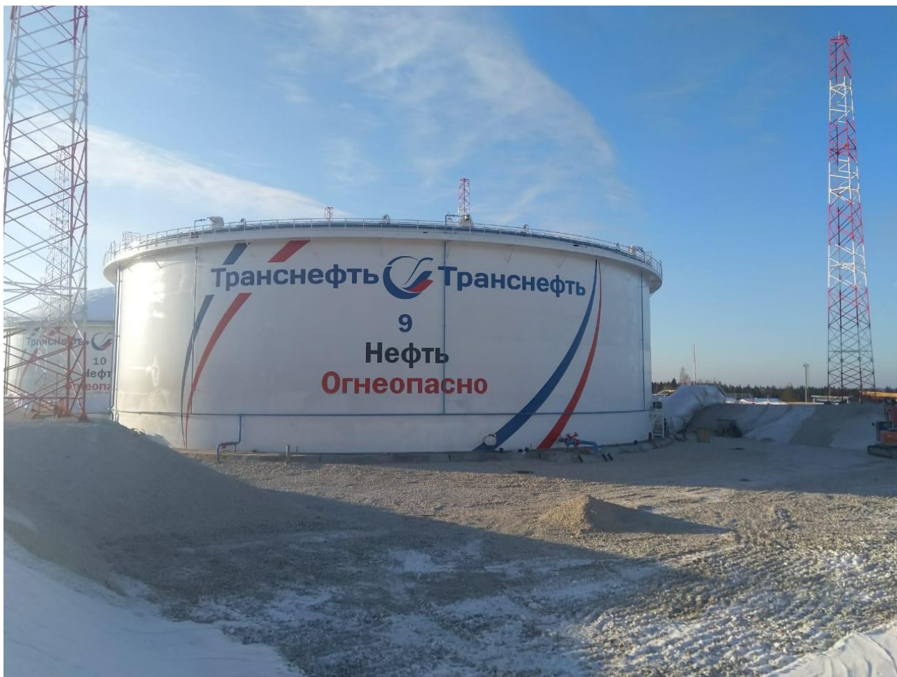
Рисунок 1 – Общий вид резервуара РВСПК-50000
