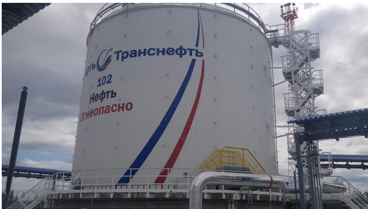
Рисунок 1 – Общий вид резервуаров РВС-2000
