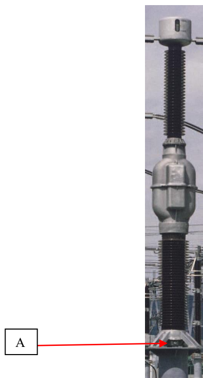
Рисунок 1 – Общий вид средства измерений и обозначение места пломбировки от несанкционированного доступа (А)
