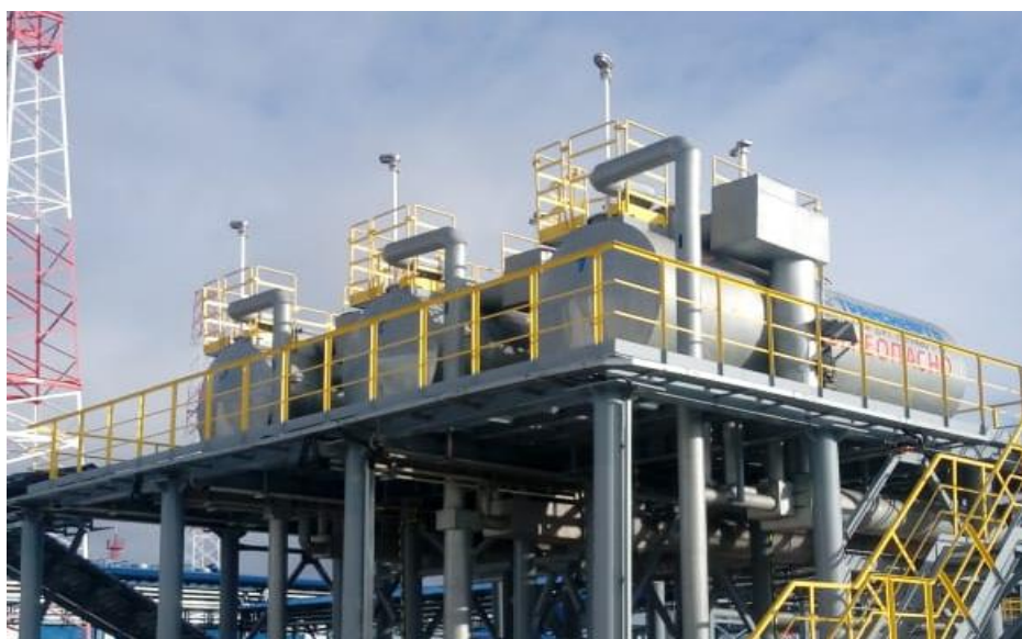
Рисунок 2 – Общий вид наземных резервуаров РГС-17 зав.№№ 262, 263, 264
