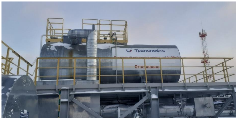
Рисунок 5 – Общий вид наземных резервуаров РГС-20 зав.№№ 281, 282
