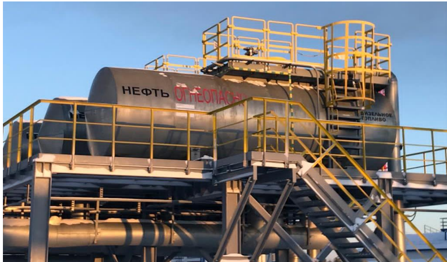
Рисунок 3 – Общий вид наземных резервуаров РГС-17 зав.№№ 260, 261, 267
