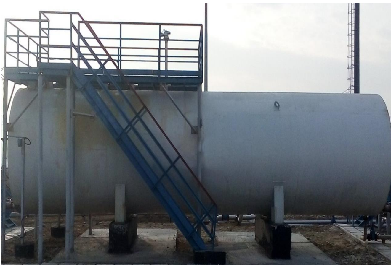
Рисунок 3 – Общий вид резервуара стального горизонтального цилиндрического РГС-100
