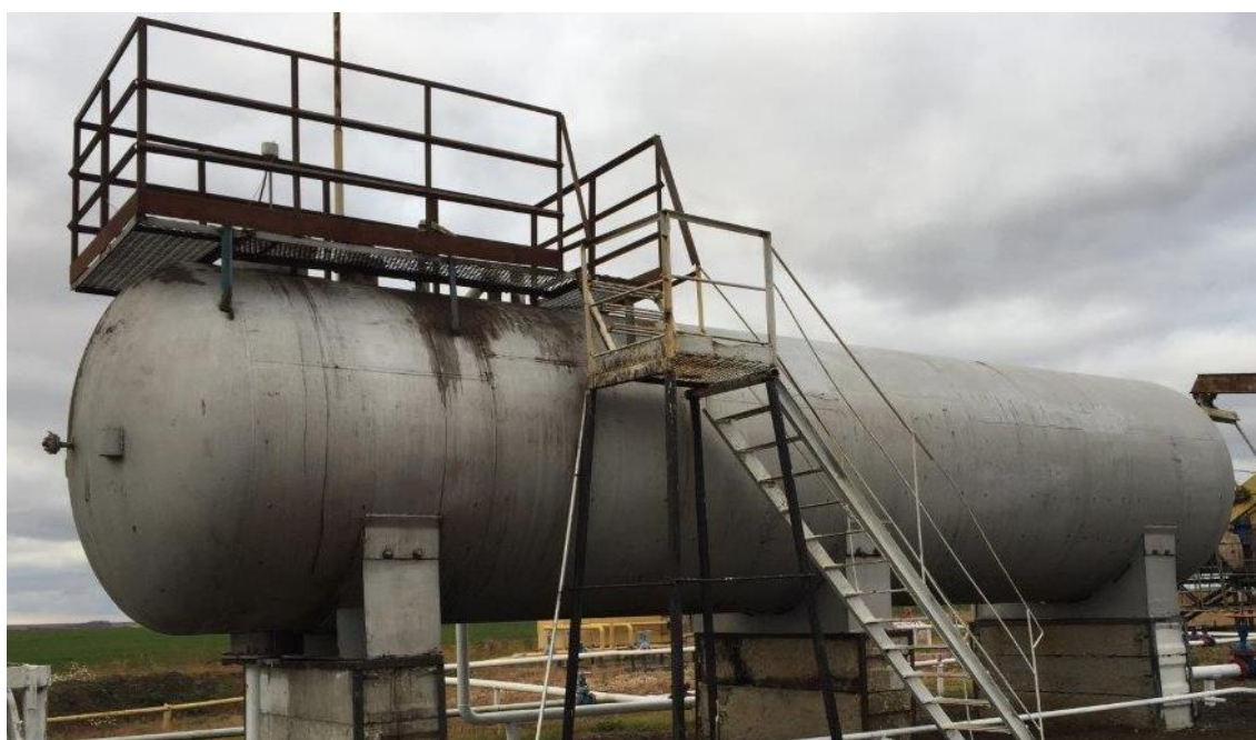
Рисунок 2 – Общий вид резервуара стального горизонтального цилиндрического РГС-60
