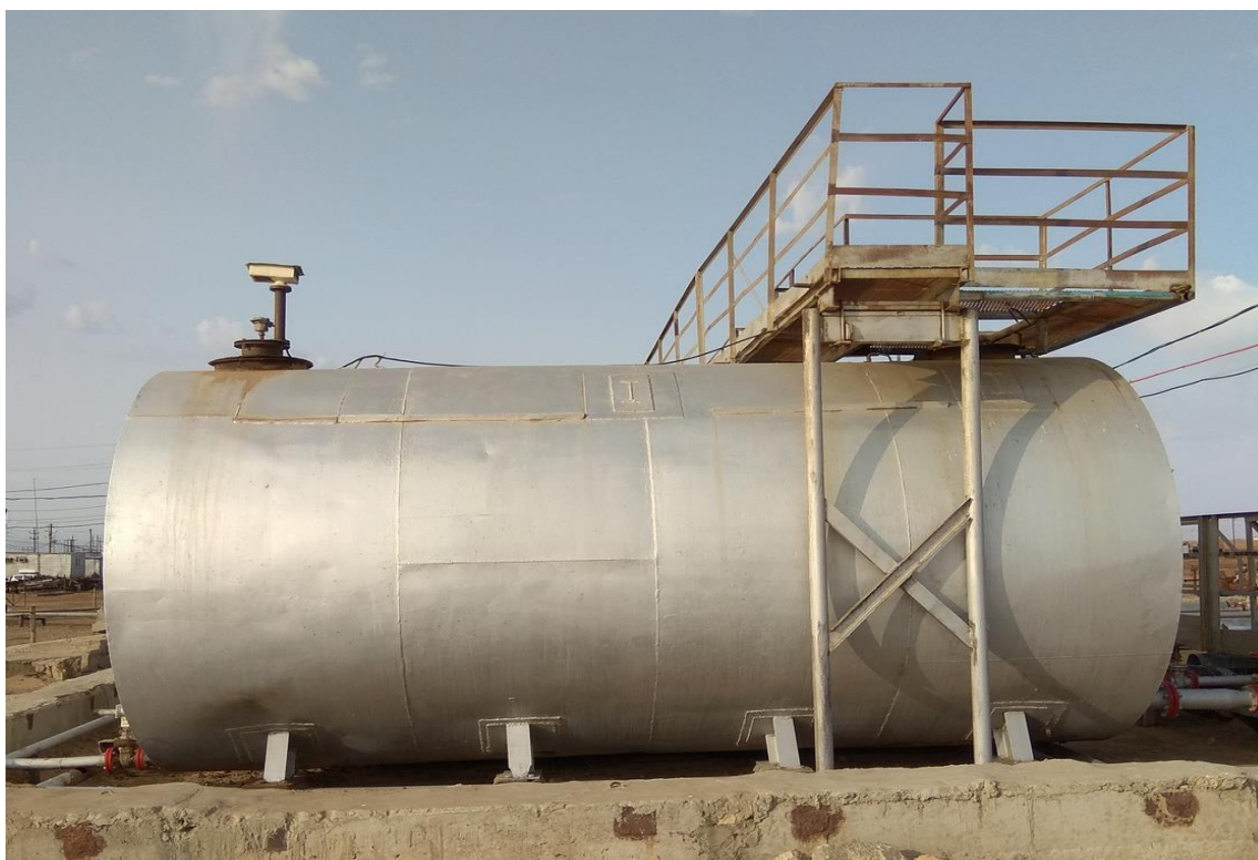
Рисунок 1 – Общий вид резервуара стального горизонтального цилиндрического РГС-50
