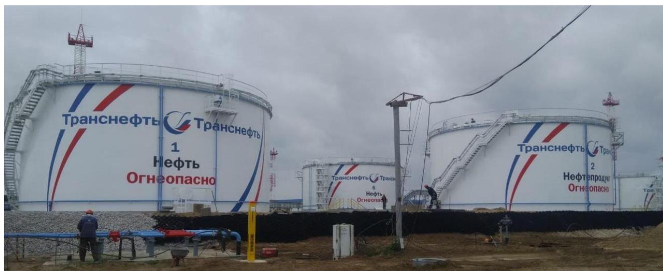
Рисунок 1 – Общий вид резервуаров вертикальных стальных цилиндрических РВСП-5000, РВС-5000, заводские номера 1 и 2
