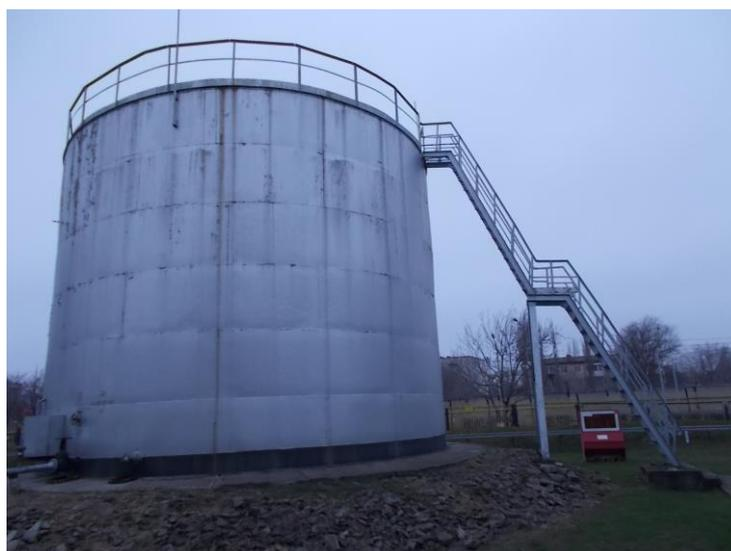
Рисунок 1 – Общий вид резервуаров стальных вертикальных цилиндрических РВС-700
