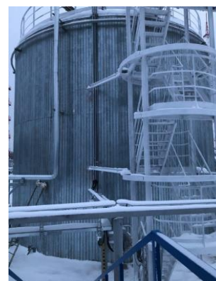
Рисунок 2 – Общий вид резервуара с зав. № 108
