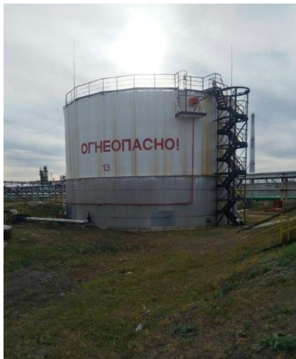
Рисунок 2 – Общий вид резервуаров стальных вертикальных цилиндрических РВС-3000
