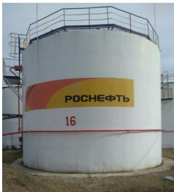
Рисунок 1 – Общий вид резервуаров стальных вертикальных цилиндрических РВС-1000
