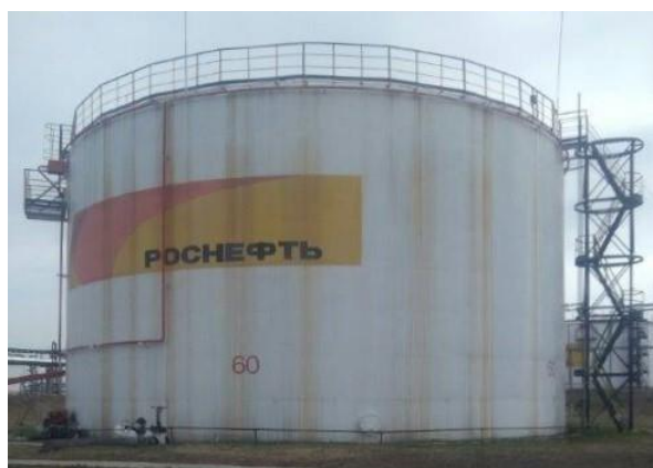
Рисунок 3 – Общий вид резервуаров стальных вертикальных цилиндрических РВС-5000
