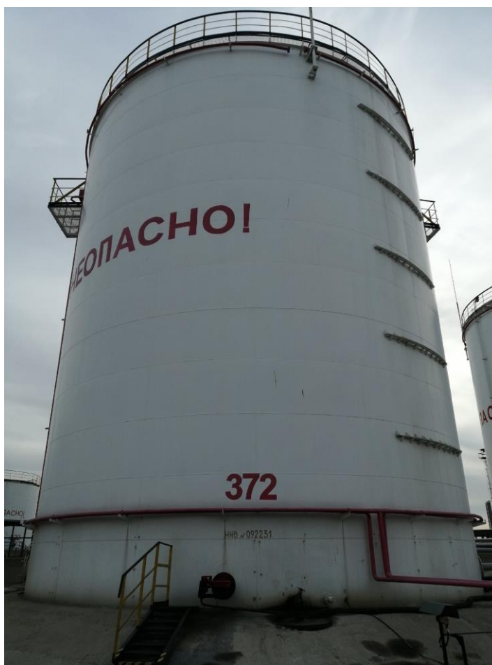
Рисунок 3 – Общий вид резервуаров стальных вертикальных цилиндрических РВС-3000
