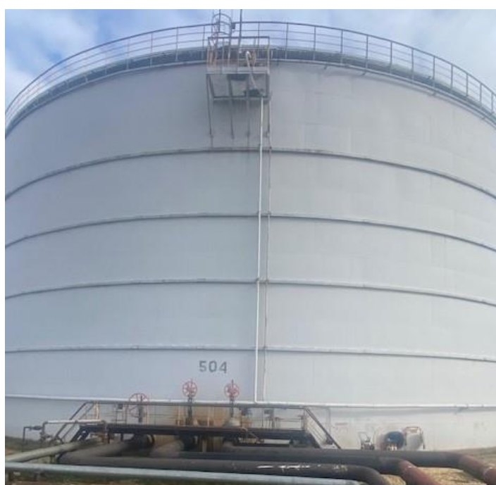
Рисунок 7 – Общий вид резервуаров стальных вертикальных цилиндрических РВСPI-20000
