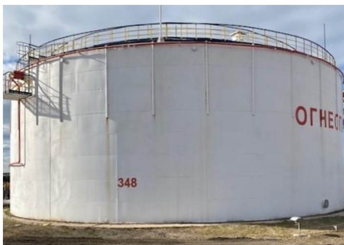
Рисунок 5 – Общий вид резервуаров стальных вертикальных цилиндрических РВС-10000
