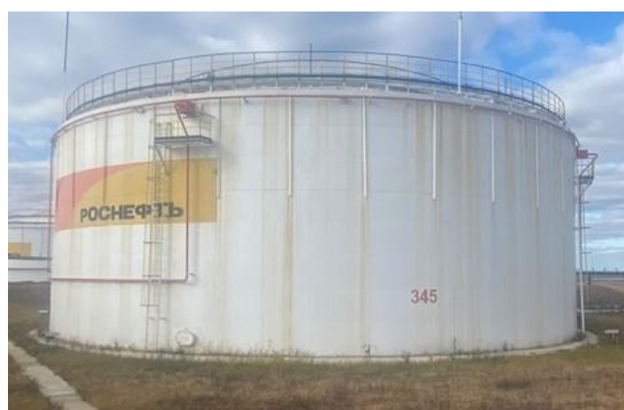
Рисунок 6 – Общий вид резервуаров стальных вертикальных цилиндрических РВСPI-10000
