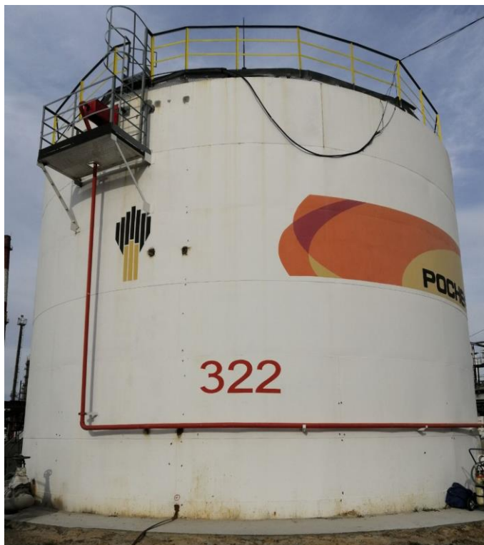
Рисунок 1 – Общий вид резервуаров стальных вертикальных цилиндрических РВС-1000
