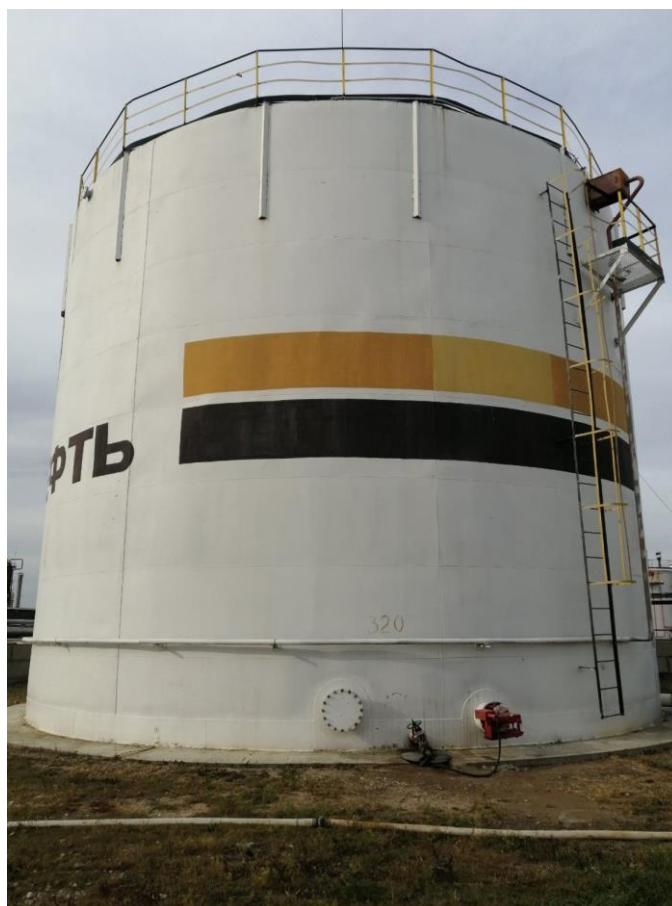
Рисунок 2 – Общий вид резервуаров стальных вертикальных цилиндрических РВС-2000
