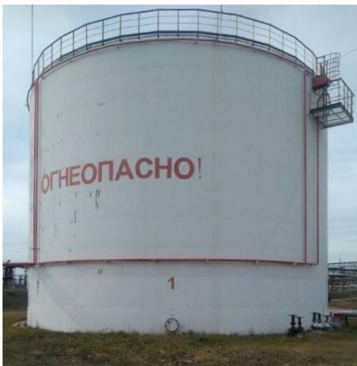
Рисунок 4 – Общий вид резервуаров стальных вертикальных цилиндрических РВС-5000
