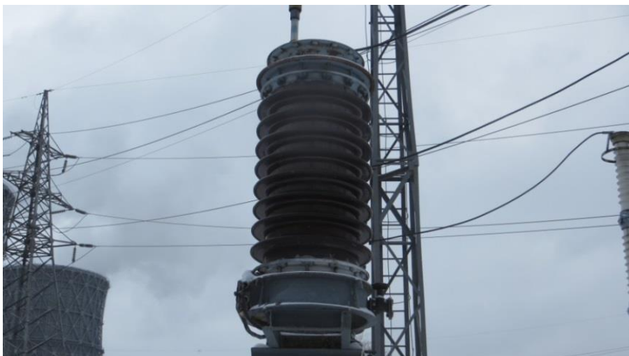
Рисунок 1 - Общий вид трансформаторов
