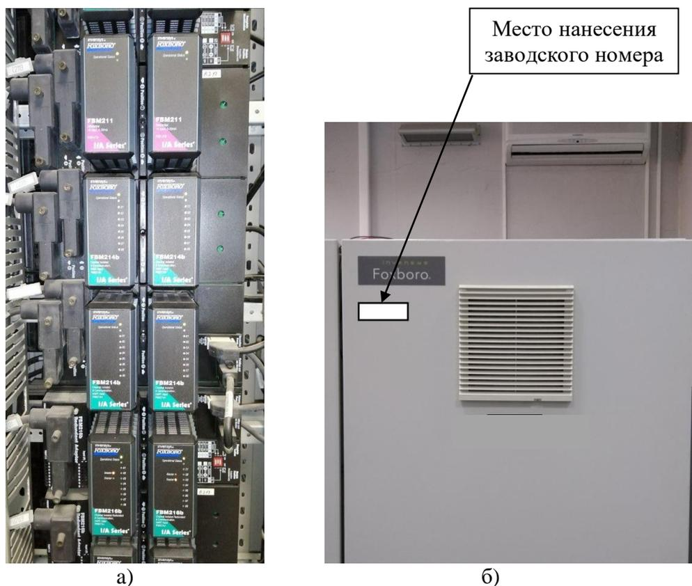
Рисунок 2 - Шкаф управления системы: а) система в сборе; б) место расположения таблички
