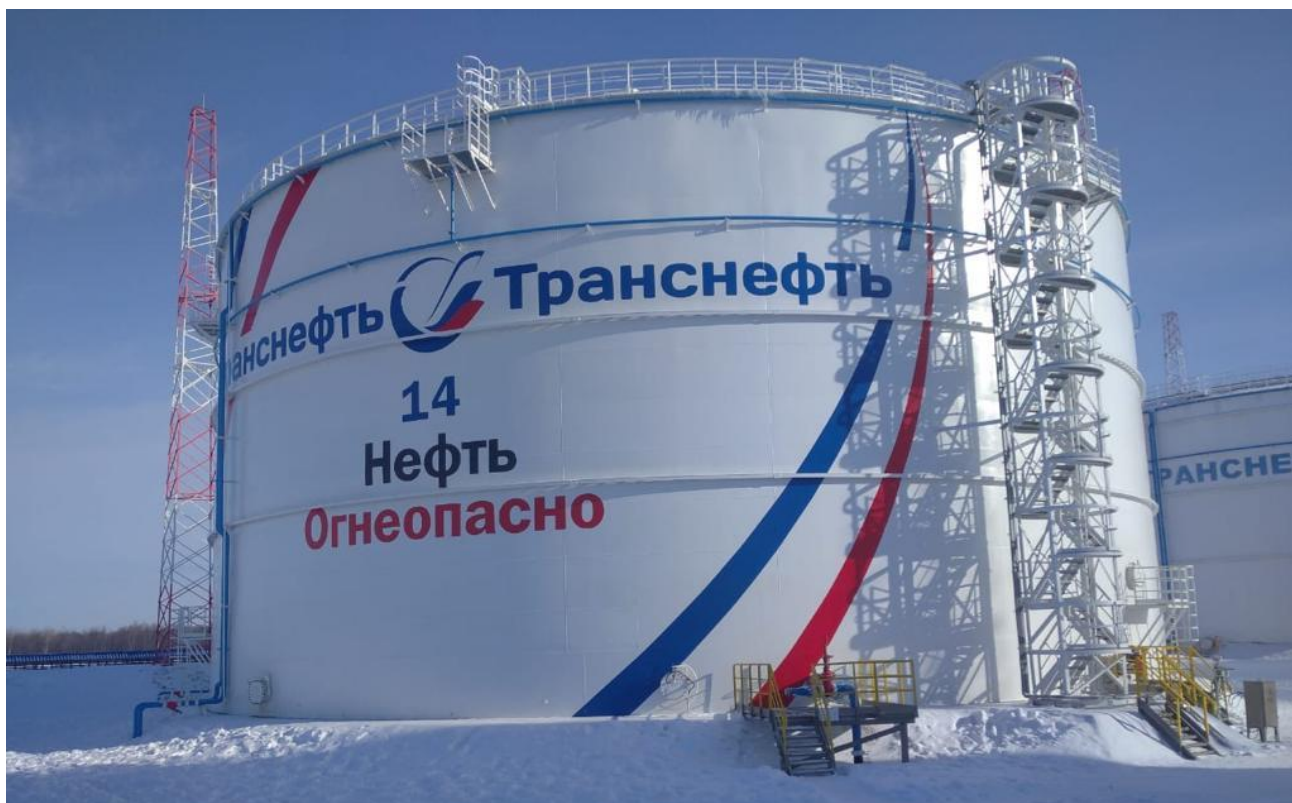
Рисунок 1 – Общий вид резервуара РВСП-20000
