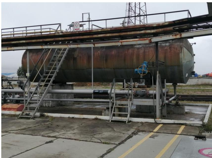
Рисунок 1 – Общий вид резервуаров стальных горизонтальных цилиндрических РГС-50
