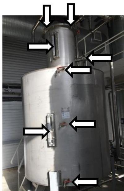
Рисунок 2 – Схема пломбировки мерника МТ-ВИЦ-250Н, зав.№ 21-68/05-04 от несанкционированного доступа, обозначение места нанесения знака поверки
