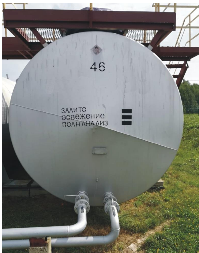
Рисунок 3 – Общий вид резервуаров РГС-50
