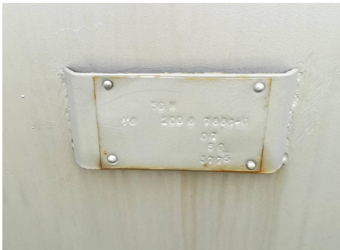
Рисунок 7 – Общий вид резервуаров РГС-50 зав.№46
