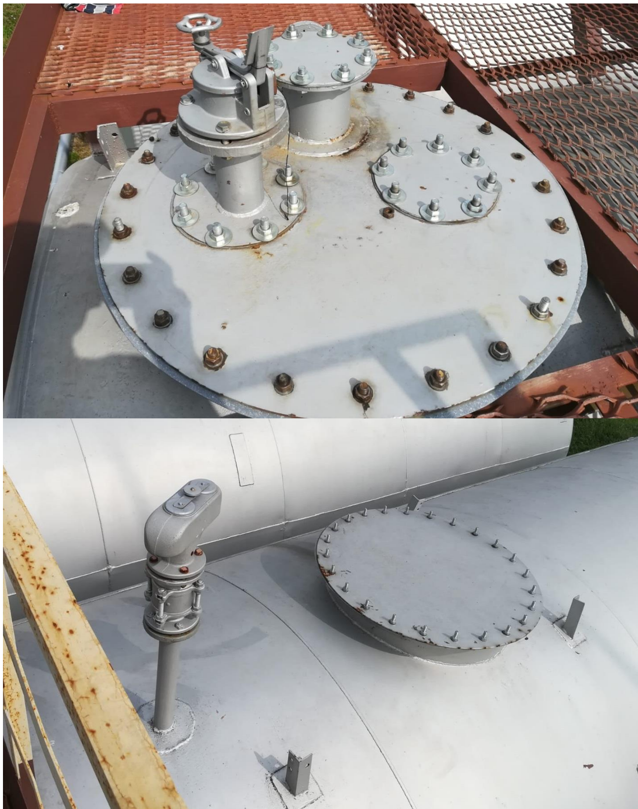
Рисунок 5 – Общий вид резервуаров РГС-50
