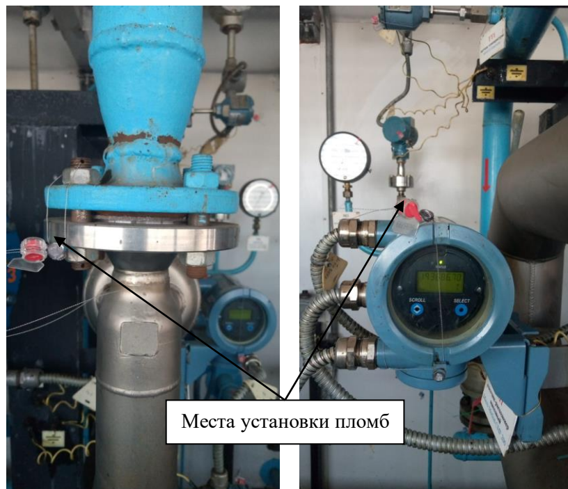
Рисунок 2 – Схема пломбировки от несанкционированного доступа
