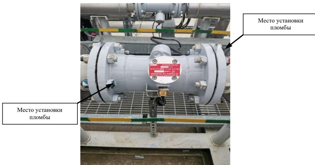
Рисунок 2 – Места установки пломб на ТПР
