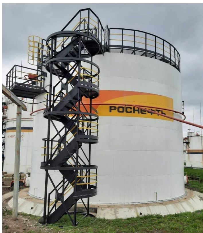
Рисунок 2 – Общий вид резервуаров РВС-1000
