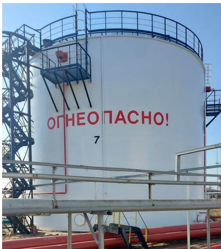
Рисунок 3 – Общий вид резервуаров РВС-2000
