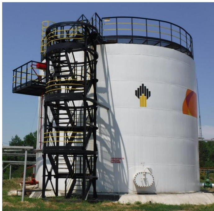
Рисунок 1 – Общий вид резервуаров РВС-700
