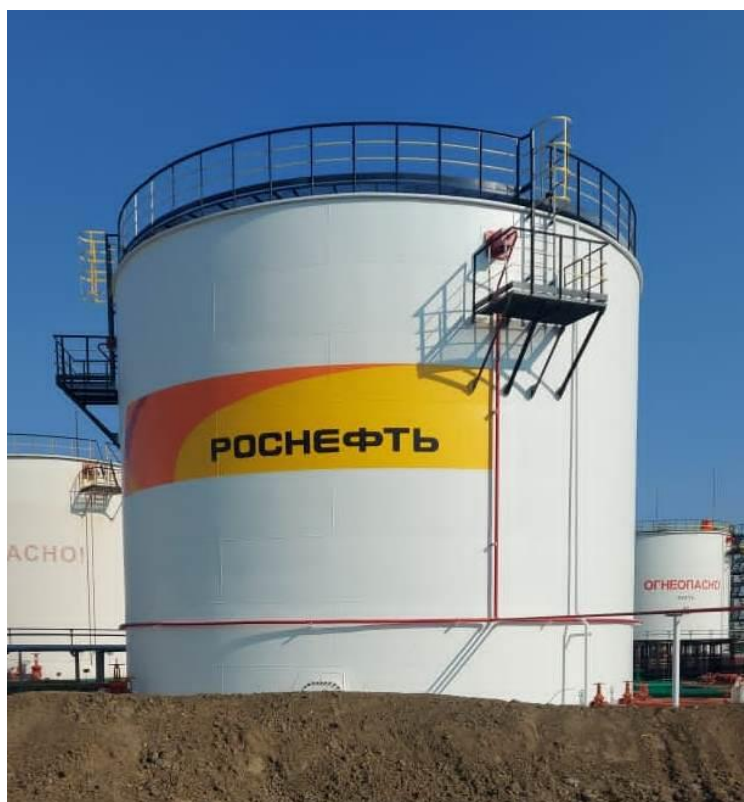
Рисунок 4 – Общий вид резервуаров РВС-5000
