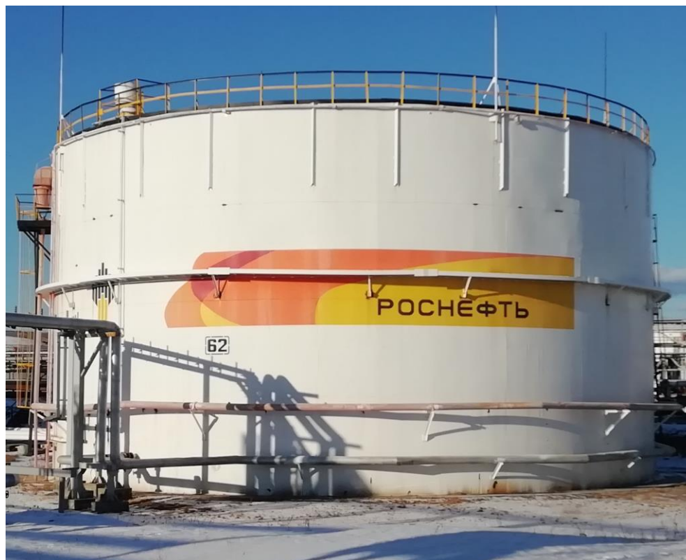
Рисунок 3 – Общий вид резервуаров РВС-5000
