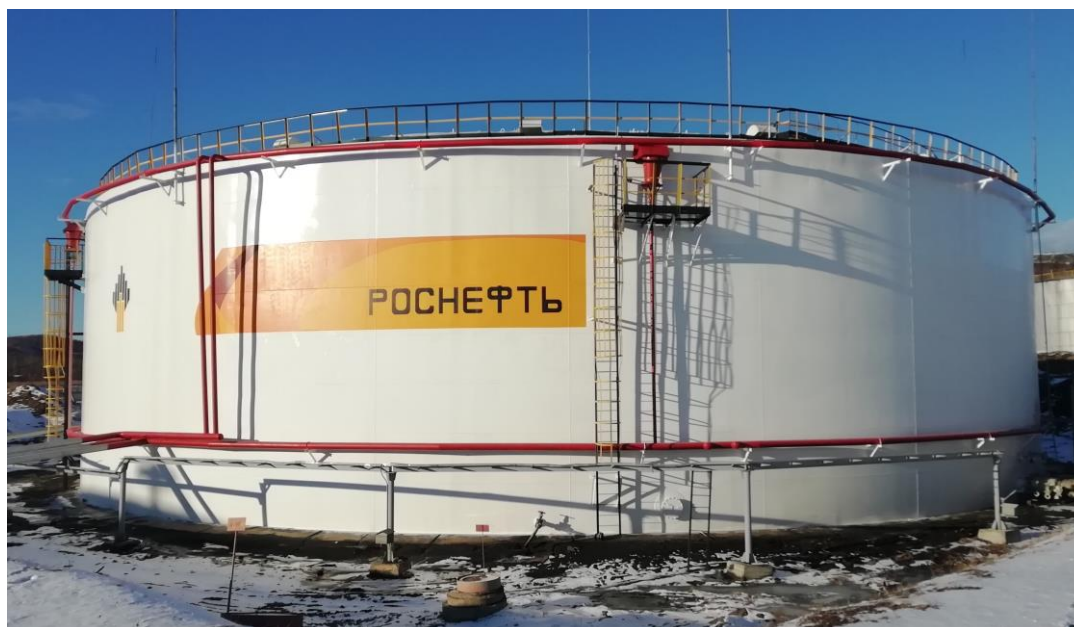
Рисунок 5 – Общий вид резервуара РВСП-20000
