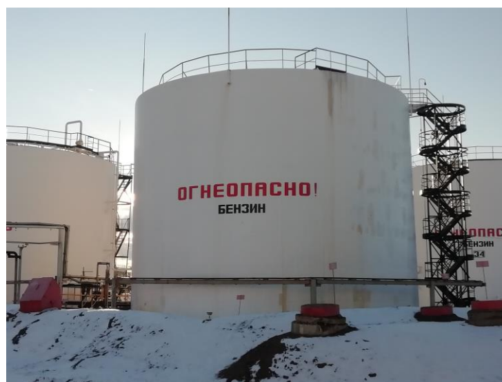
Рисунок 1 – Общий вид резервуара РВС-2000
