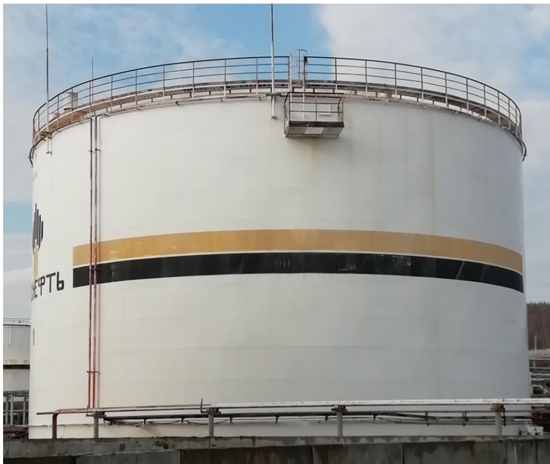
Рисунок 4 – Общий вид резервуаров РВС-10000
