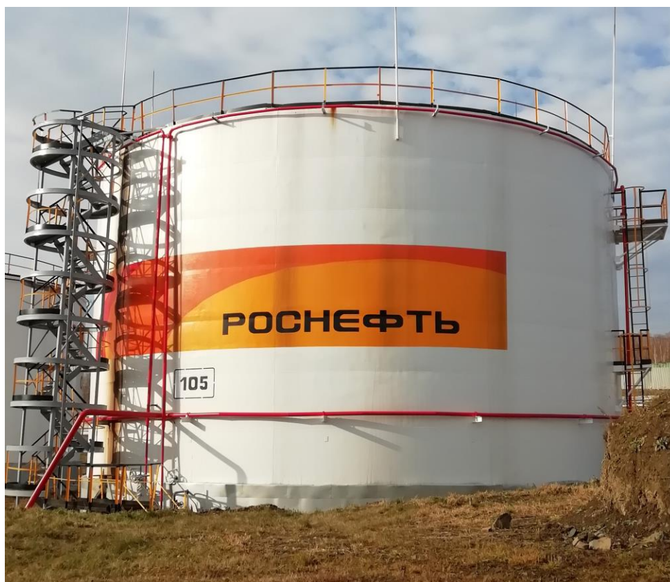
Рисунок 2 – Общий вид резервуаров РВС-3000
