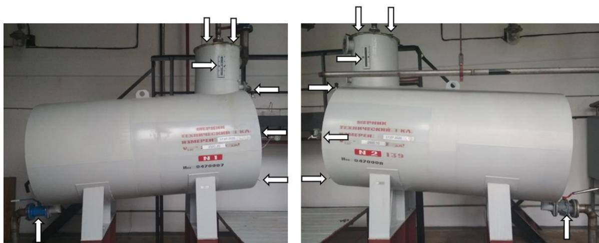
Рисунок 2 – Схема пломбировки мерников технических 1-го класса М1кл-2500Н, зав.№№ 1, 2 от несанкционированного доступа, обозначение места нанесения знака поверки
