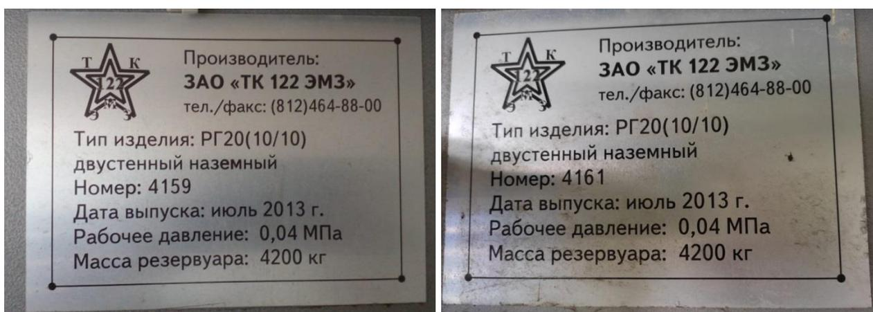
Рисунок 3 – Маркировочные таблички резервуаров РГС-20
