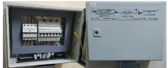
Рисунок 8 – Щит распределительный питания
