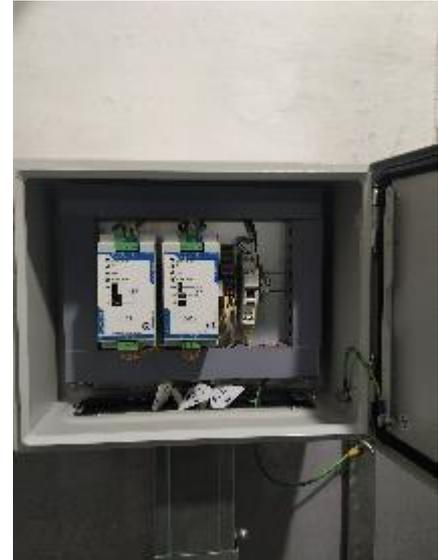
Рисунок 6 – Шкаф БП МВР с блоками питания
