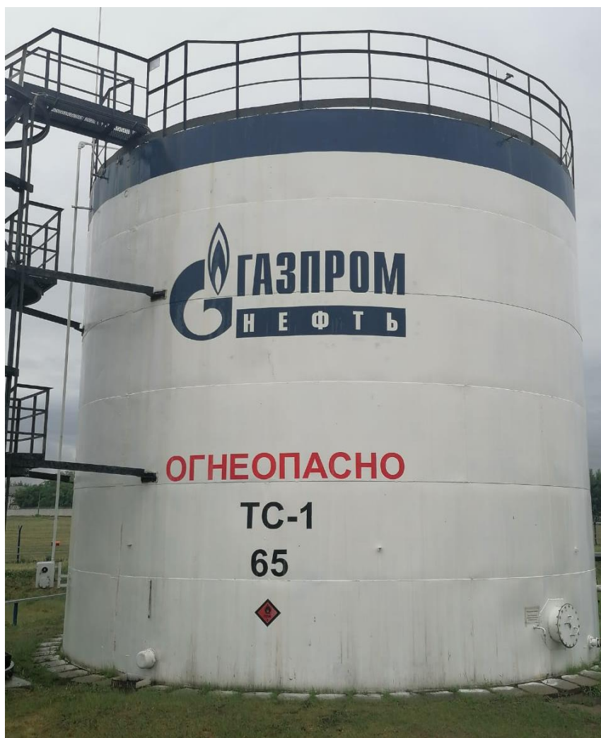
Рисунок 1 – Общий вид резервуара РВС-700
