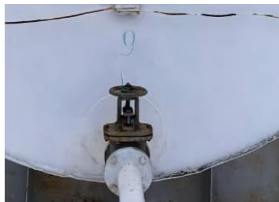
Рисунок 1 – Место и способ нанесения заводских номеров
