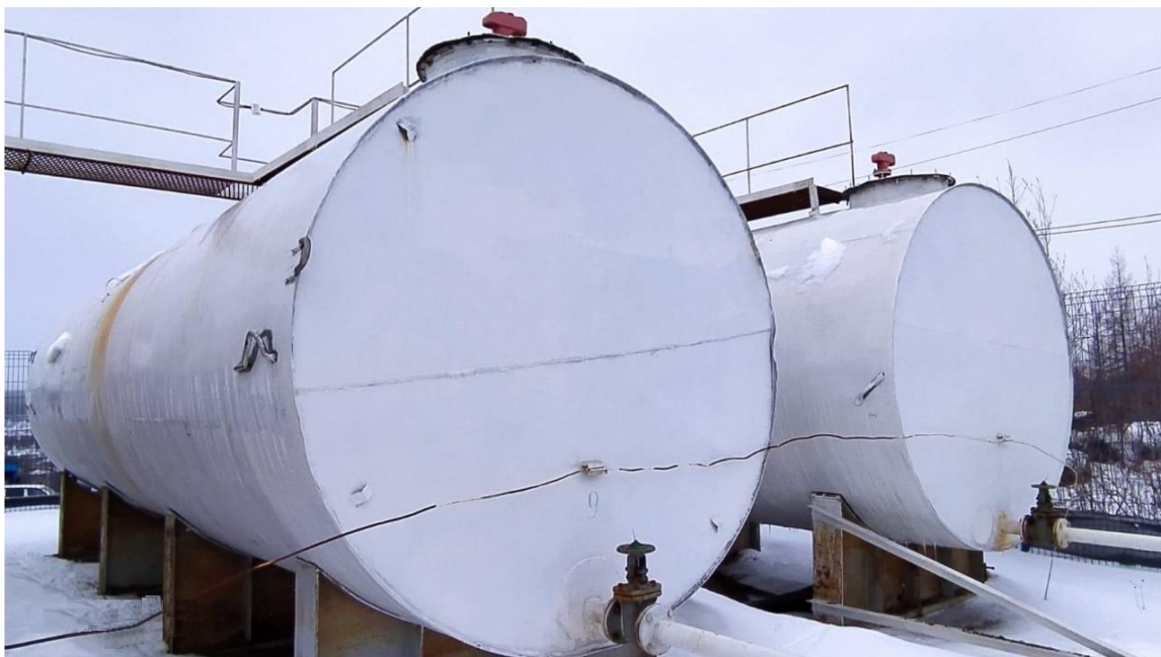
Рисунок 2 – Общий вид резервуаров РГС-50
