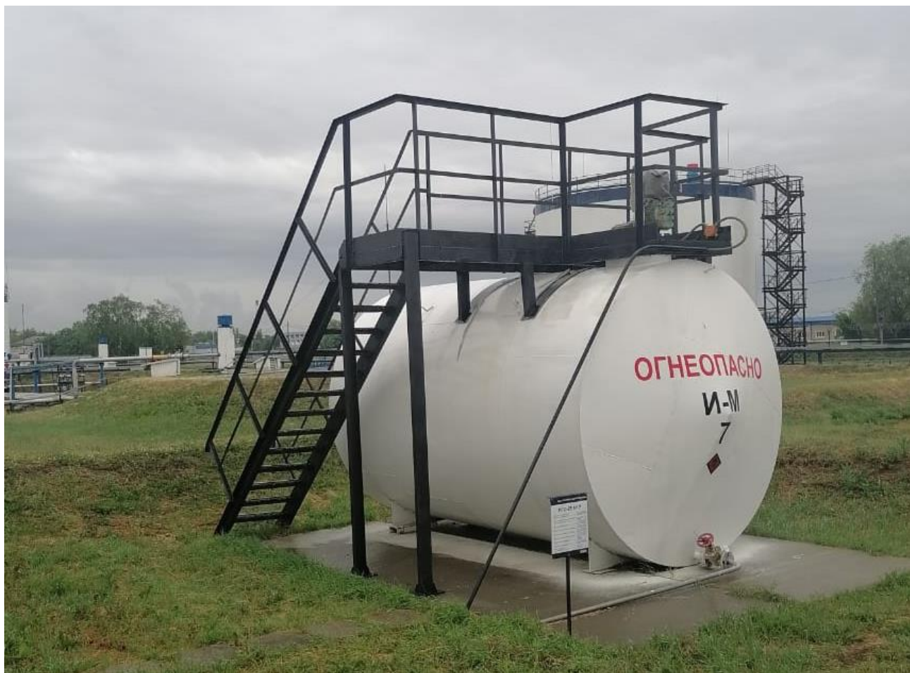
Рисунок 1 – Общий вид резервуара РГС-25
