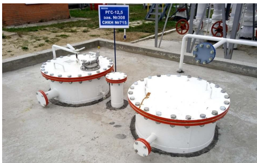
Рисунок 1 – Общий вид резервуара РГС-12,5 зав.№ 308
