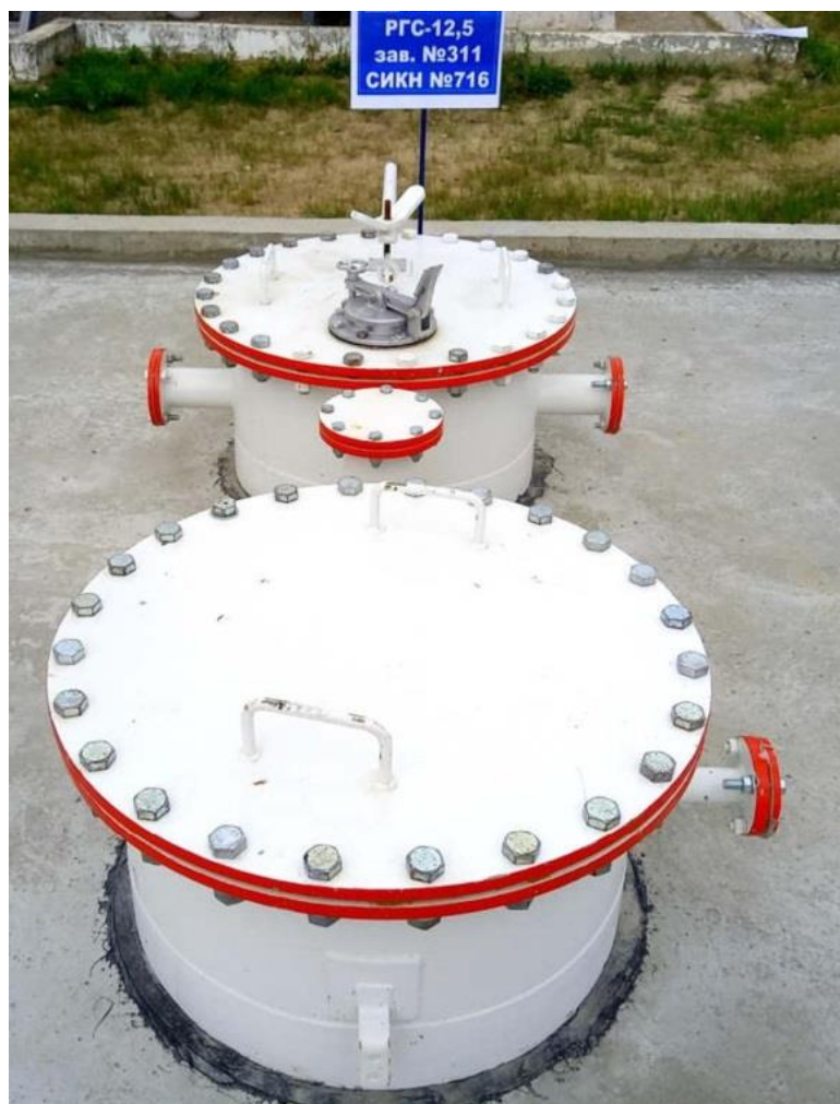
Рисунок 4 – Общий вид резервуара РГС-12,5 зав.№ 311
