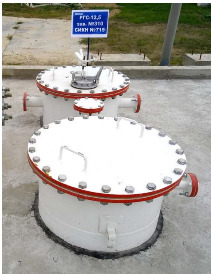
Рисунок 3 – Общий вид резервуара РГС-12,5 зав.№ 310
