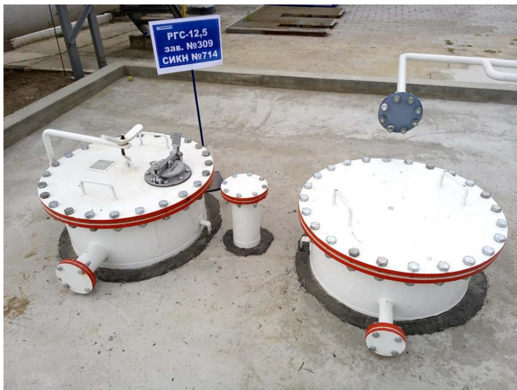
Рисунок 2 – Общий вид резервуара РГС-12,5 зав.№ 309
