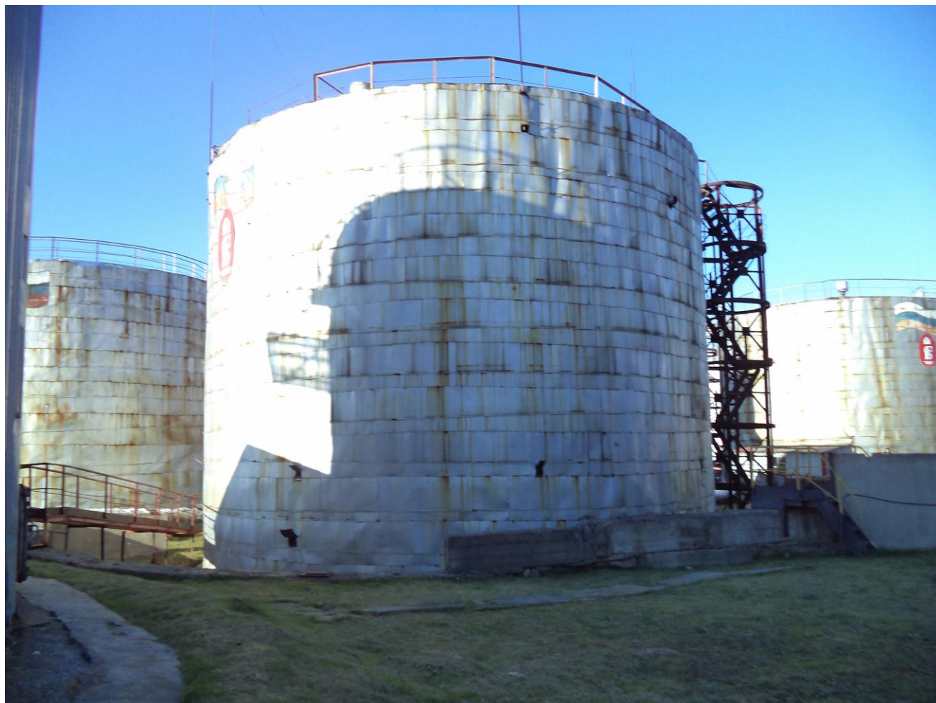
Рисунок 1 – Общий вид резервуара
