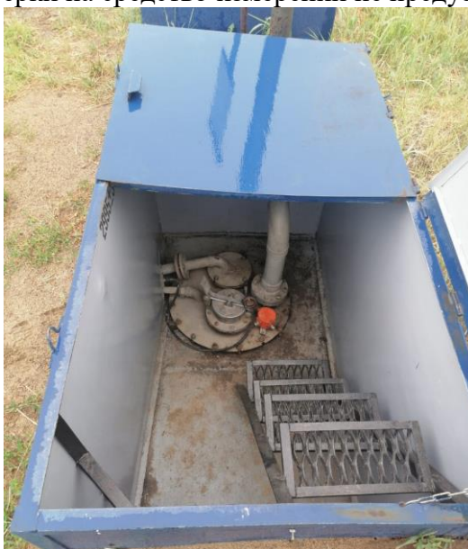
Рисунок 1 – Общий вид резервуара РГС-25
