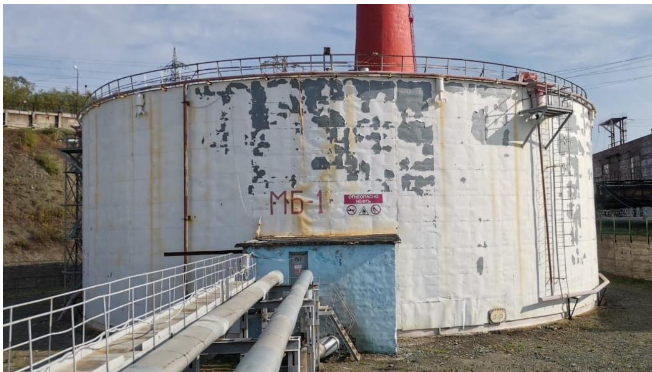
Рисунок 1 – Общий вид резервуара РВС-10000
