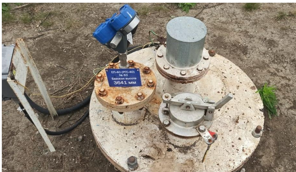
Рисунок 1 – Общий вид резервуара РГС-40
