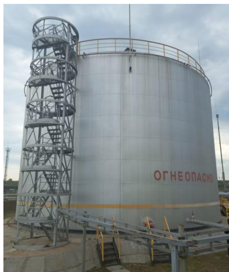
Рисунок 1 – Общий вид резервуаров стальных вертикальных цилиндрических РВС-3000
