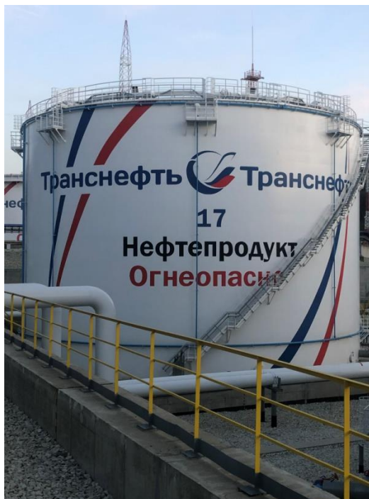
Рисунок 3 – Общий вид резервуара РВСП-20000 зав.№ 17
