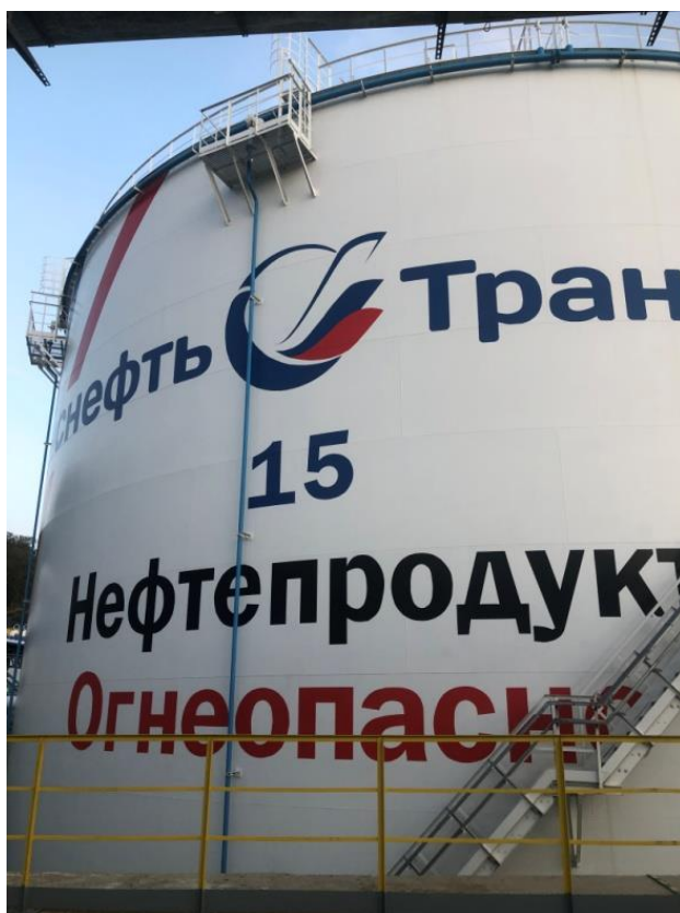
Рисунок 1 – Общий вид резервуара РВСП-20000 зав.№ 15
