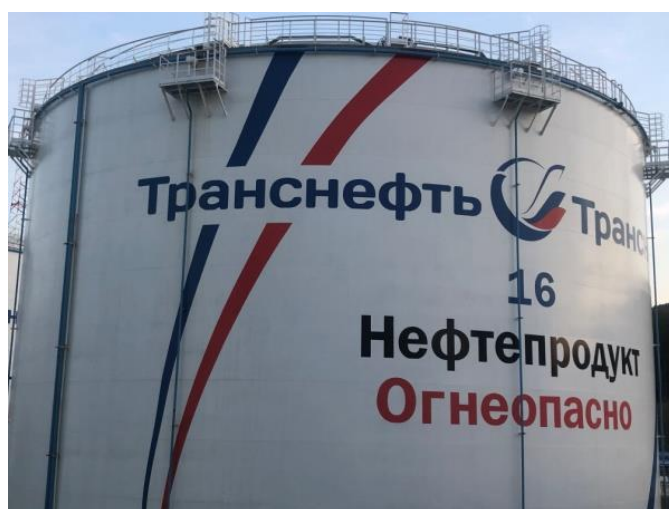
Рисунок 2 – Общий вид резервуара РВСП-20000 зав.№ 16
