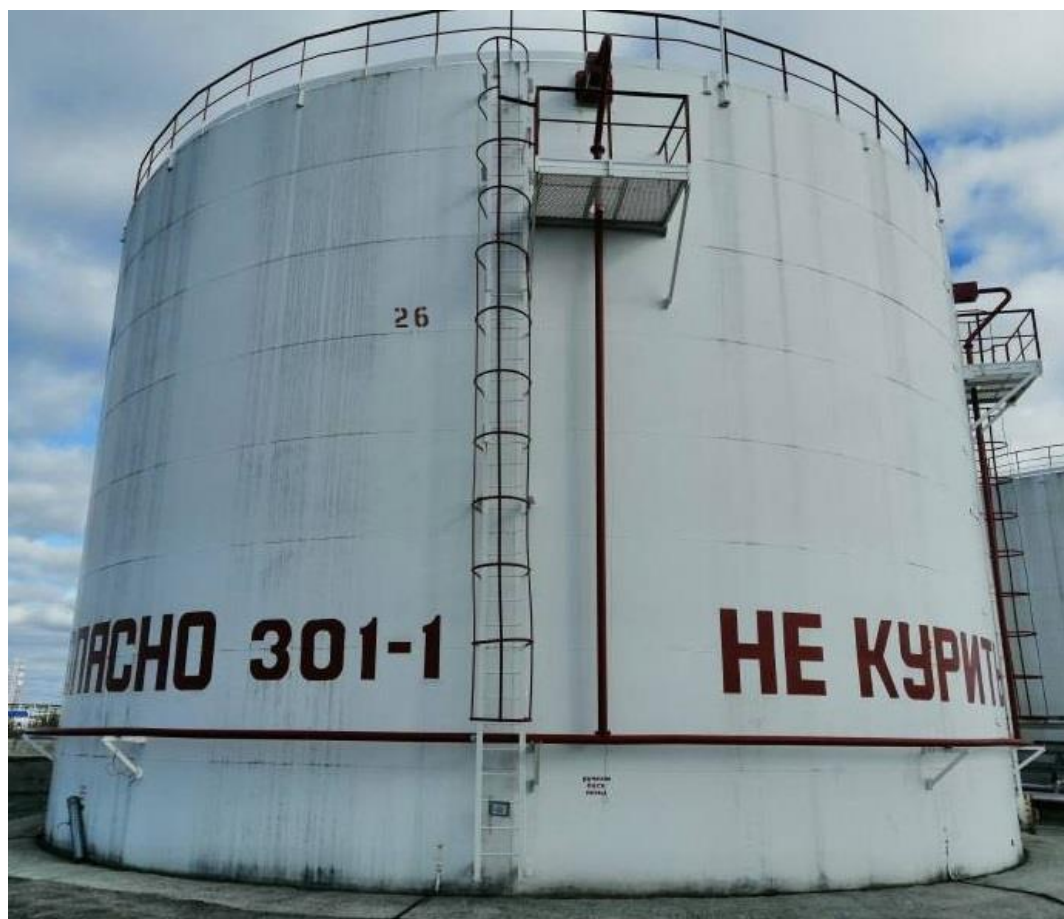
Рисунок 1 – Общий вид резервуаров РВС-3000
