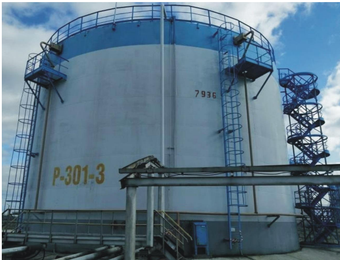
Рисунок 3 – Общий вид резервуаров РВС-3000
