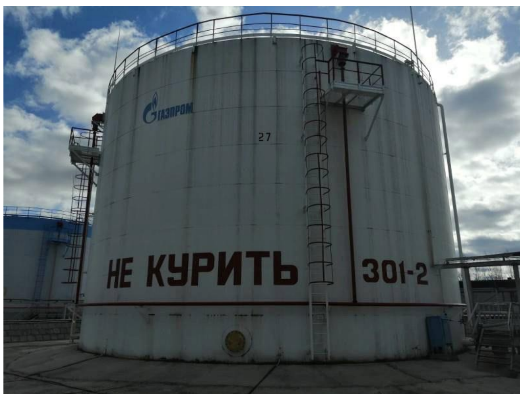
Рисунок 2 – Общий вид резервуаров РВС-3000
