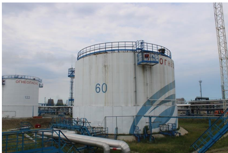
Рисунок 1 – Общий вид резервуара стального вертикального цилиндрического РВС-3000.
