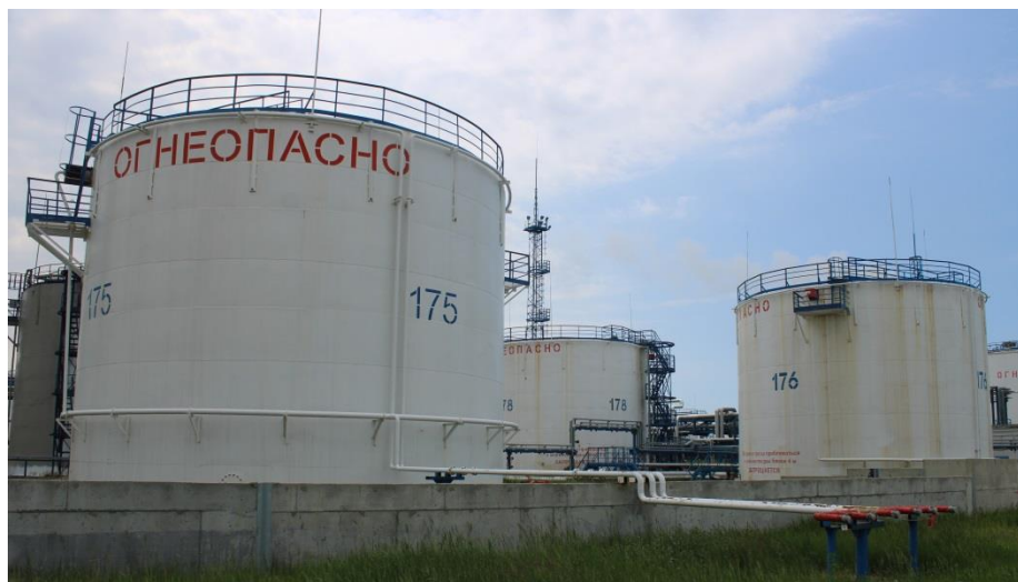
Рисунок 1 – Общий вид резервуаров стальных вертикальных цилиндрических РВС-2000
