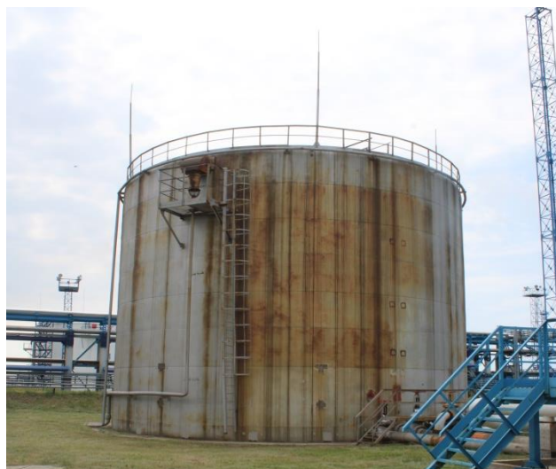
Рисунок 1 – Общий вид резервуара стального вертикального цилиндрического РВС-2000
