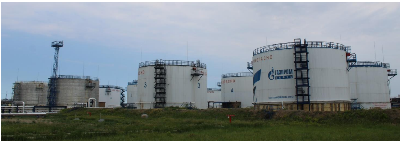
Рисунок 1 – Общий вид резервуаров стальных вертикальных цилиндрических РВС-3000
