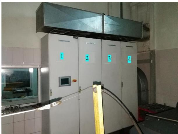
Рисунок 1 – Шкафы комплекса (1 – шкаф автоматического управления комплекса, 2 – шкаф инвертора, 3 – шкаф выпрямителя, 4 – шкаф ввода питания)
