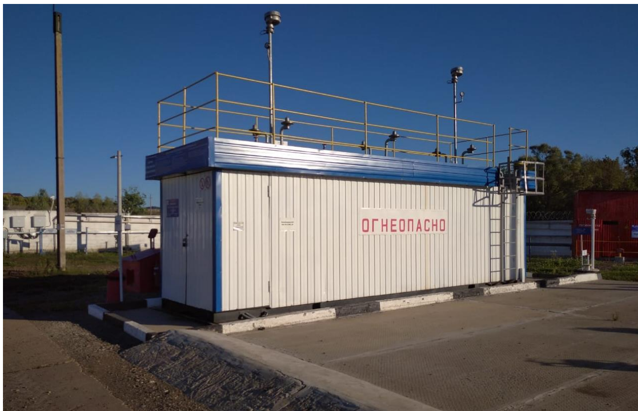
Рисунок 1 – Общий вид резервуара РГС-20
