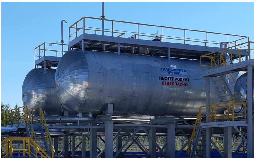
Рисунок 1 – Общий вид резервуаров РГС-100
