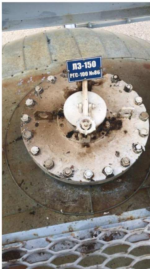
Рисунок 3 – Общий вид резервуара РГС-100 зав.№ 86
