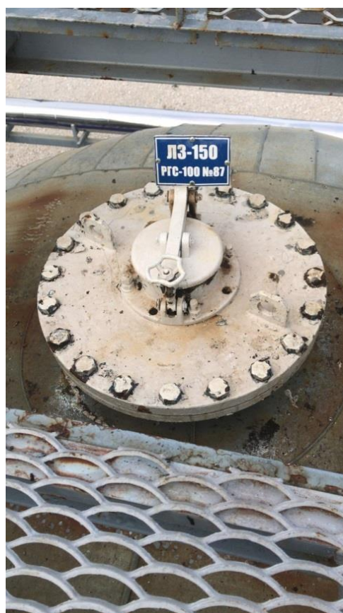
Рисунок 2 – Общий вид резервуара РГС-100 зав.№ 87
